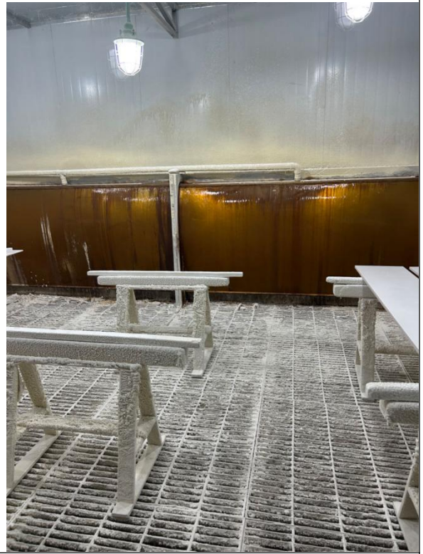
水帘、循环水池
